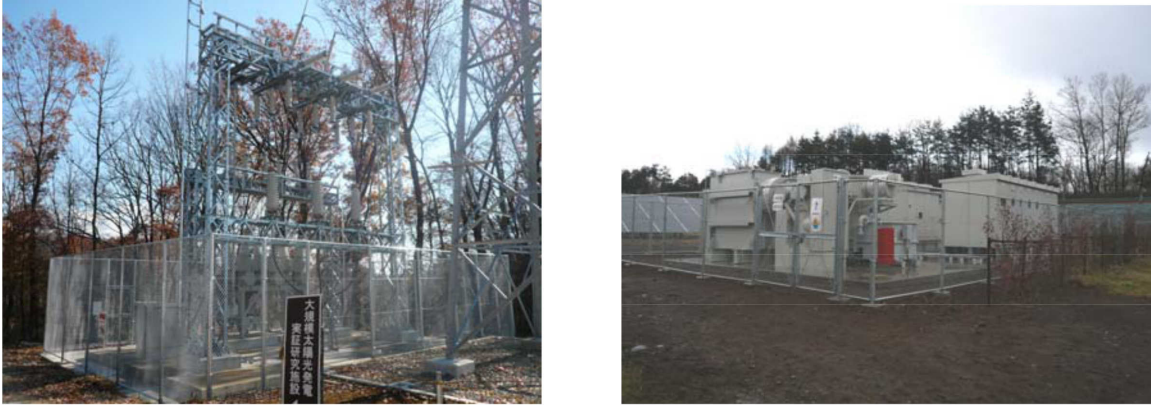
図2.3-7 特高開閉所の例（左図：開閉所、右図：変電所）
